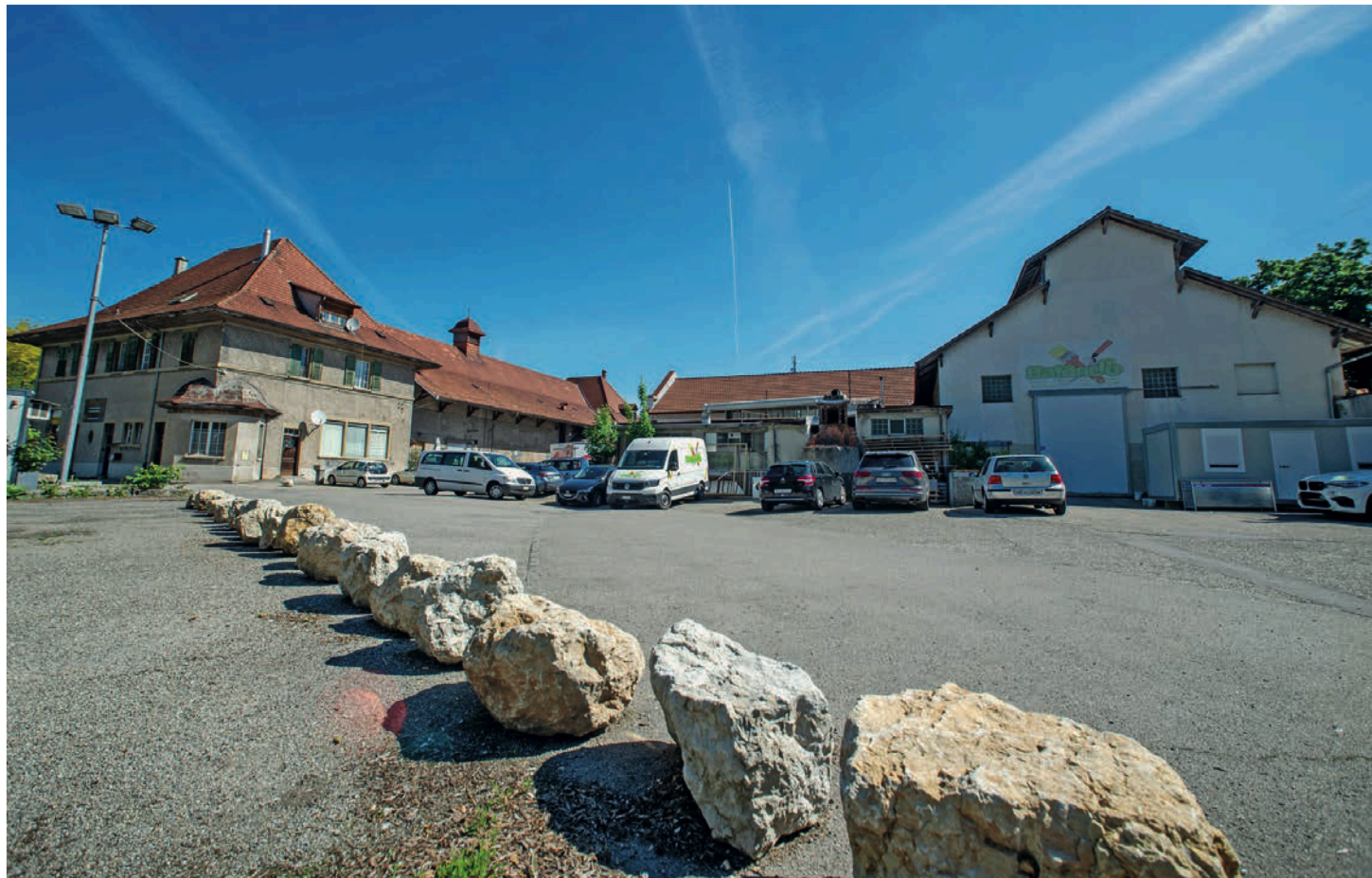
Dieser vernachlässigte Platz soll möglichst schnell wieder belebt werden.
