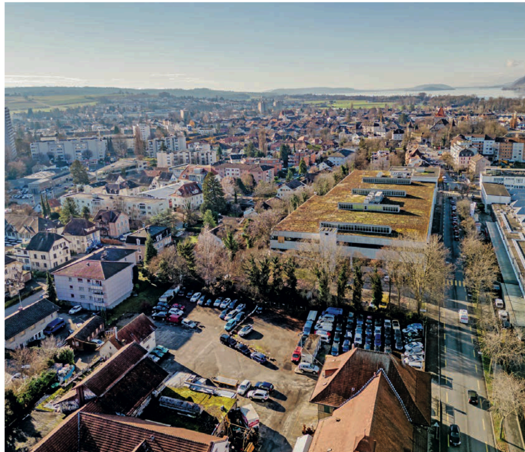
Das Gebäude mit dem begrünnten Flachdach an der Salzhausstrasse 18 in Biel soll aufgestockt werden.
